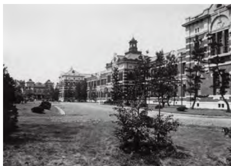
工科大学本館(大正3年竣工)
