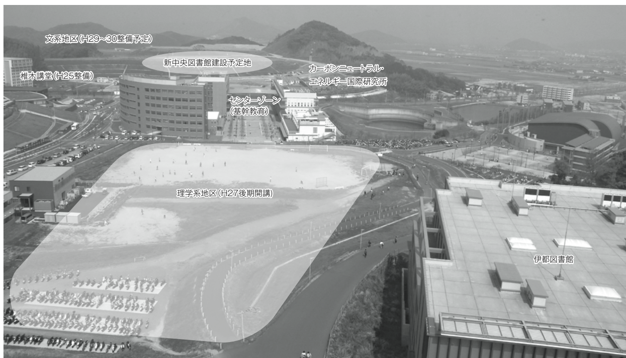
工学系地区より伊都キャンパス東側を望む(2012年5月撮影)
