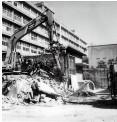
玉泉館解体(昭和62年10月14日)
