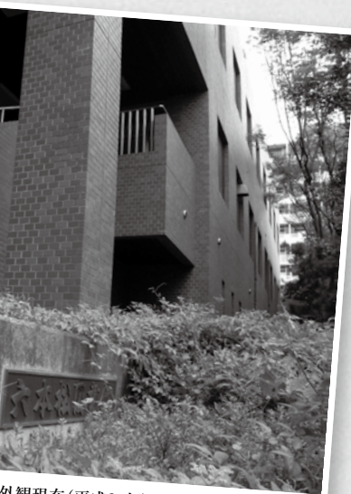
外観現在（平成20年）
